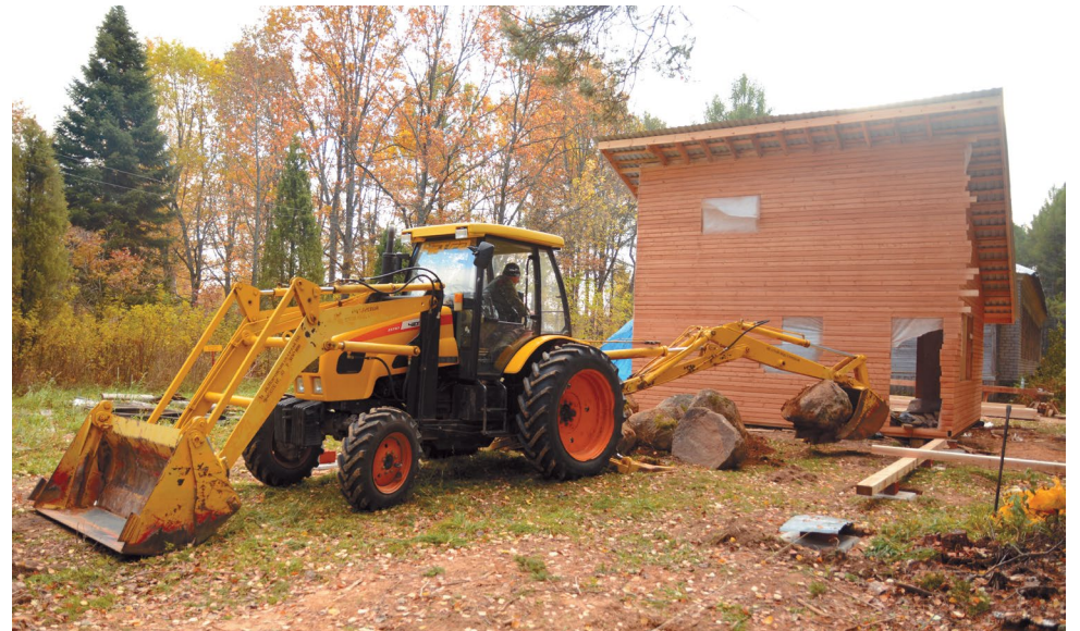
Сооружение присад из камней, на помощь пришел Александр Семериков на экскаваторе. Сентябрь 2015 г. Фото Мирослава Бабушкина
